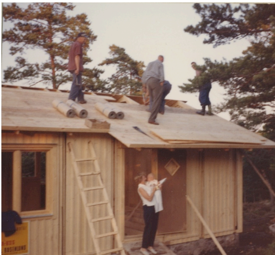
Kallvikens hus är från Olsson & Rosenlund. Här kommer taket på plats
